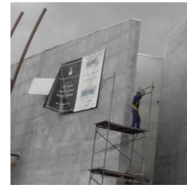
Fachada executada com perfis de aço sem função estrutural. Os perfis foram instalados para fixação do revestimento.
