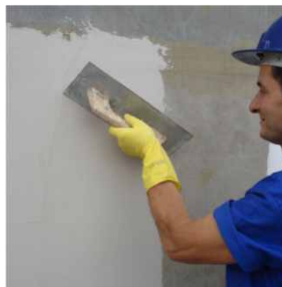
Utilize a desempenadeira em ângulo para facilitar a aplicação
