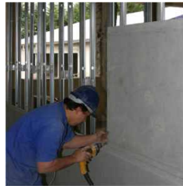
Parede interna não estrutural com perfis de aço sendo revestida com a placa cimentícia BRICKAWALL
