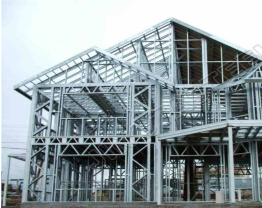
Construção em Light Steel Frame (LSF)- estrutura em aço galvanizado
