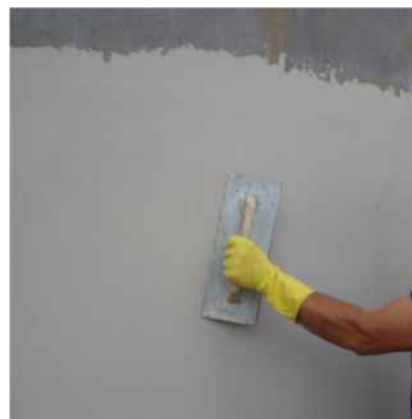
Aplicação da massa nivelante sobre toda a superfície da placa para se obter um acabamento liso.
