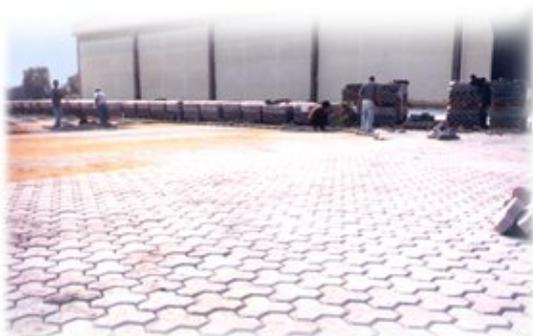
**Macopá** utiliza blocos de concreto BRICKA 12 de alta resistência em área de tráfego pesado de cargas industriais
