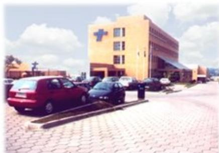
BRICKA 16 no pátio do **Aeroporto Internacional Afonso Pena**, na Grande Curitiba: pavimento resistente a cargas e corrosão de combustíveis beneficia áreas de tráfego leve ou pesado
