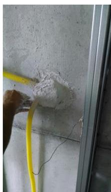
Foto 3: Detalhe da vedação das aberturas das caixas elétricas, com gesso e sisal.
