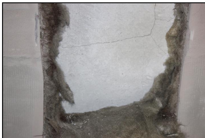
Foto 22: Detalhe da abertura que foi feita na placa. Foram verificadas rachaduras de retração por choque térmico.
