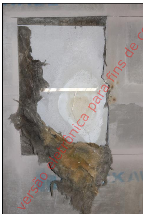
Foto 17: Abertura na placa posterior à que foi aplicada a chama. A lâ de rocha foi removida para verificação da placa na qual foi aplicada a chama.
