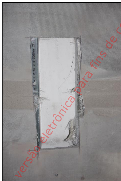
Foto 25: Abertura na placa posterior à que foi aplicada a chama. Não foram verificadas manchas nem fissuras em função do calor. As manchas observadas na parte inferior do corte são em função do pó gerado pela serra circular.
