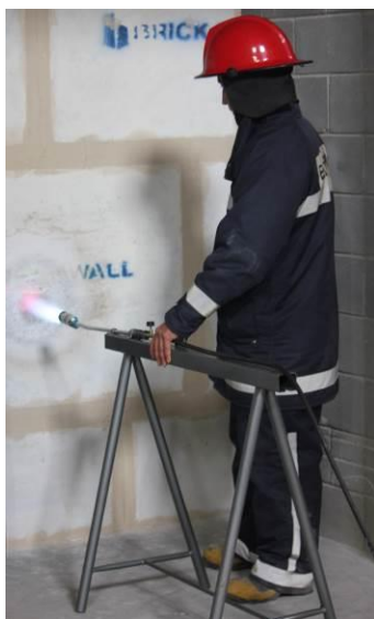
Foto 1: Maçarico abastecido com gas GLP.
