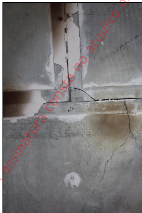
Foto 16: Detalhe de onde incidiu a chama, na amostra 211.001/2014. Podemos verificar rachaduras, decorrentes de retração por choque térmico, após a realização do ensaio.
