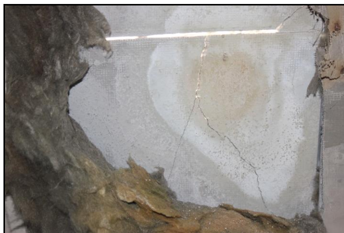
Foto 18: Detalhe da abertura que foi feita na placa. Foram verificadas manchas decorrentes do calor, bem como rachaduras de retração por choque térmico.
