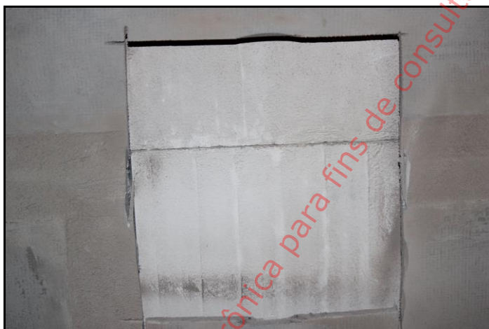
Foto 28: Abertura na placa posterior à que foi aplicada a chama. Não foram verificadas manchas nem fissuras em função do calor. As manchas observadas no contorno do corte são em função do pó gerado pela serra circular.
